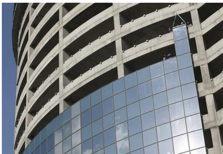
Рис. 25.1 Монтаж остекления ЖК «Лазурные небеса» (г. Казань)
