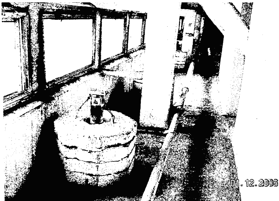
Рис. 26.2 Группа гасителей колебаний на перекрытии технического этажа здания
